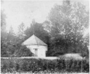
Le Puits de BAILLON. — Les Coumards.
