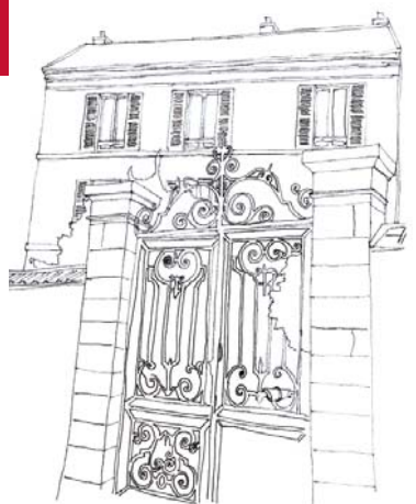
Piles de portail en pierre de taille dans un mur de clôture maçonné
