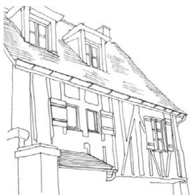
Murs à colombages et lucarnes à capucine
