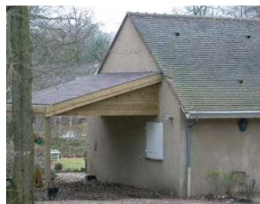
Auvents, l'un contemporain, l'autre en couverture végétale bien intégrés et accolés à la maison ou au mur de clôture
