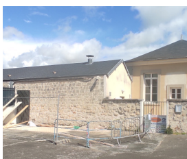
Nouvel accès d'accueil plus pratique au périscolaire d'Asnières.
