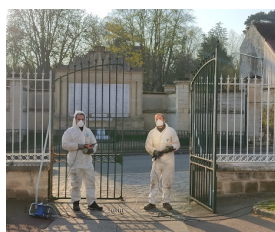
Rafraîchissement du portail et des grilles de la mairie.
