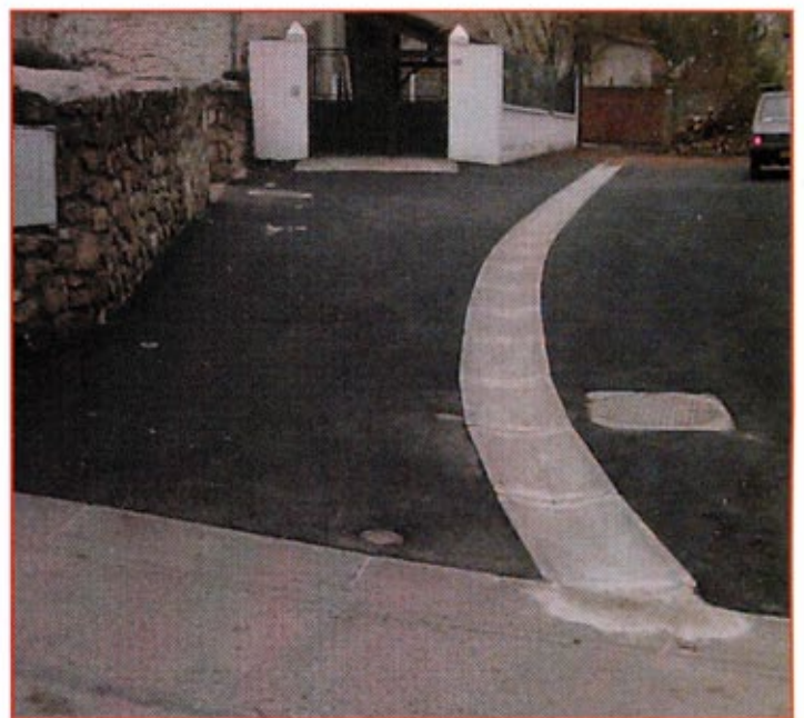
Nouveau revêtement dans la ruelle Boivin
