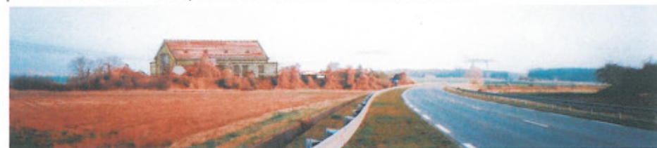
Insertion dans le site - Vue depuis la route (après construction), par JL Bollée, architecte DPLG.
