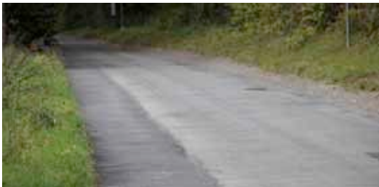
Réfection des nids de poules route de Chaumontel
