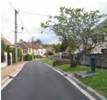
Urbanisme : Les travaux en cours
