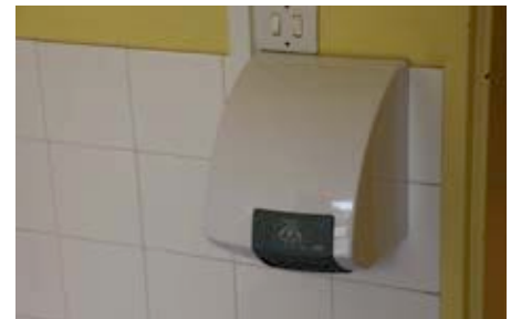
Installation de sèche mains dans les deux écoles
