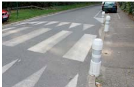
Sécurisation du passage piétons devant l'école de Baillon
