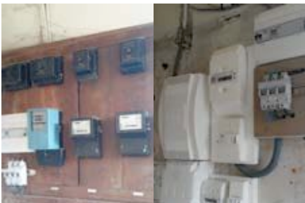
Mise aux normes du local électrique de la Mairie
