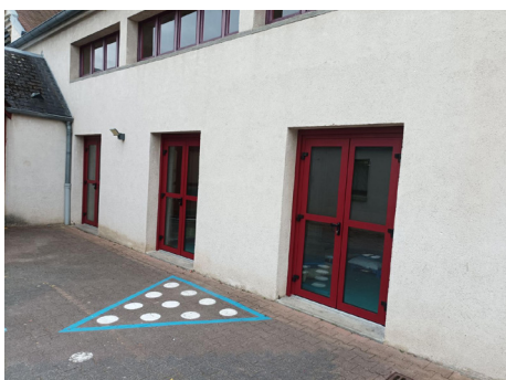
Remplacement des portes du dortoir de l'école Blanche De Castille
