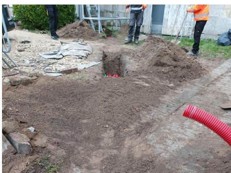
Creusement de la tranchée d'alimentation électrique du nouveau restaurant scolaire de Baillon
