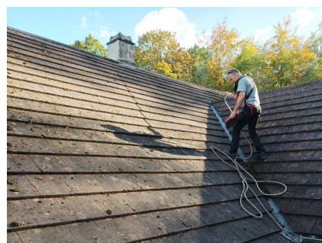
Démoussage des toitures de l'école de Baillon
