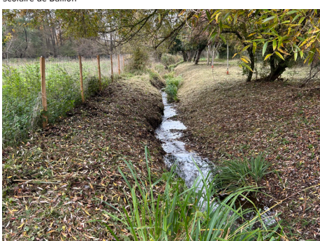
Nettoyage du fossé menant à la Thève
