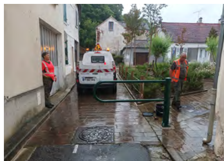
Sécurisation de la rue delchet
