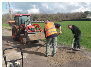
Campagne de rebouchage et de traçage
