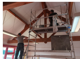
Réfection des Peintures au périscolaire
