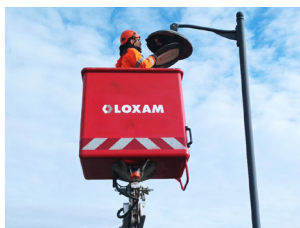
Dépannage de l'éclairage public
