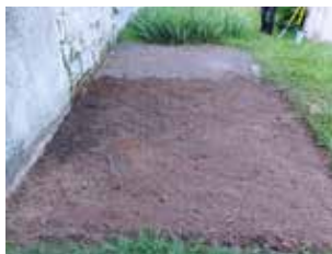
Mise en place potager de l'école du Bois Bonnet
