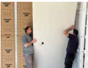
Réfection et aménagement des bureaux de la mairie
