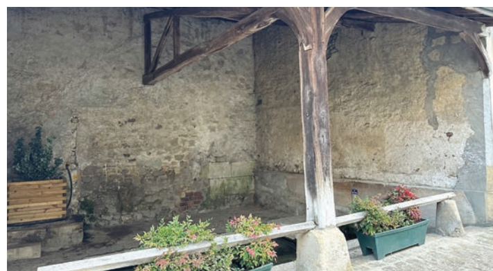
Le lavoir rue d'Aval-Eau.
