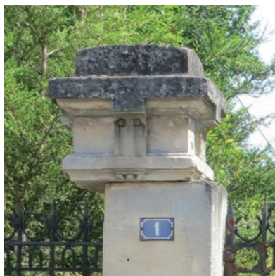
Recaler les pierres de chapiteau
