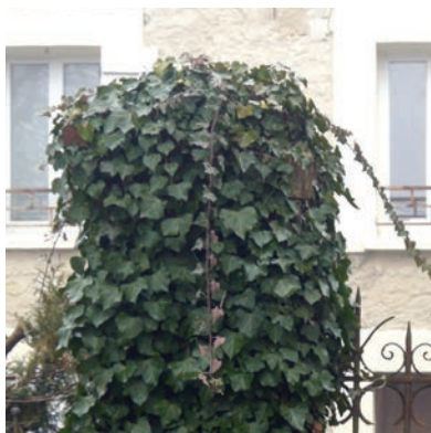
Dévégetaliser les piles et murets
