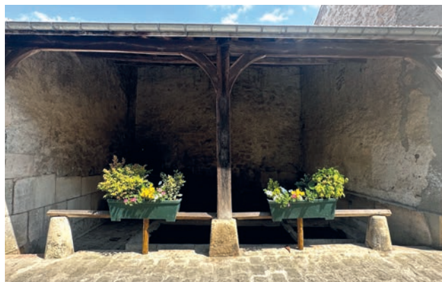
Le lavoir rue d'Aval-Eau
