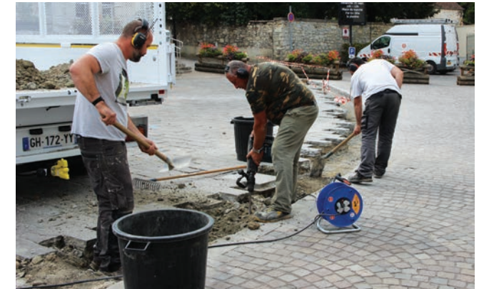
Travaux de végétalisation place de l'Église
