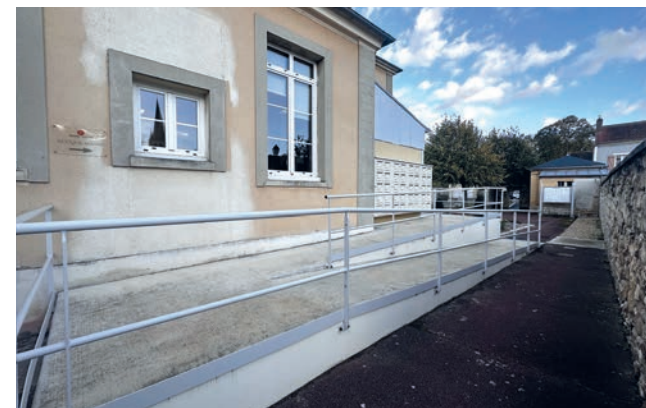
Rampe PMR à l'entrée de la mairie
